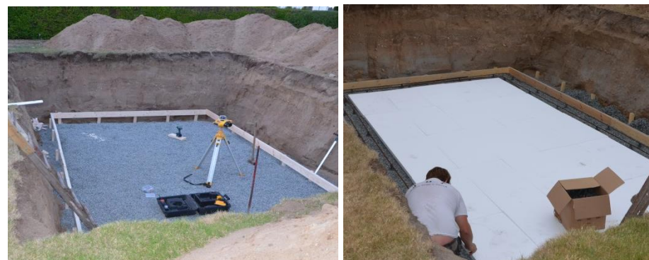
Dräneringslager, gjutform och bottenisolering.
