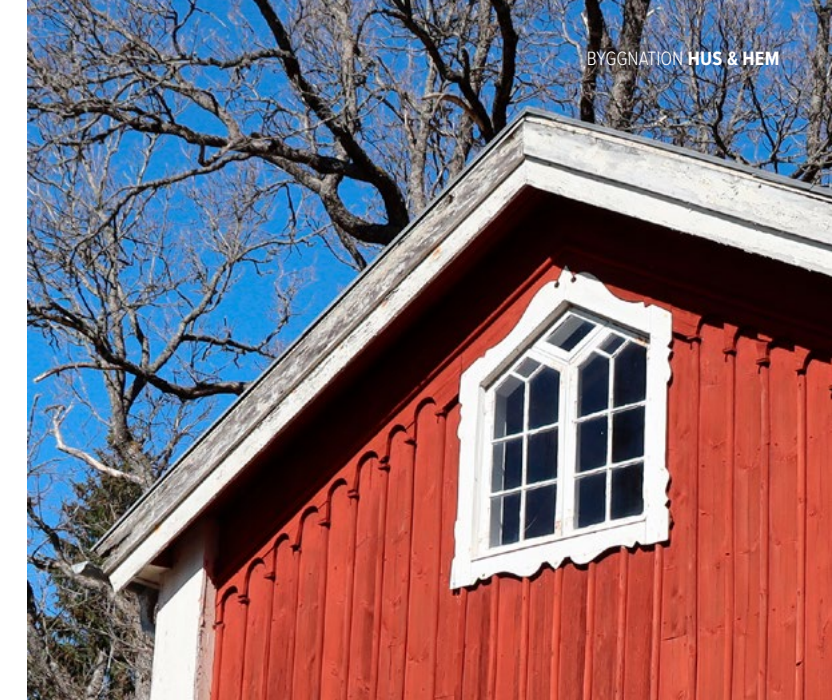
Gamla fönster ger huset en vacker karaktär. Bilden är tagen vid uppmätning av ett äldre hus.
